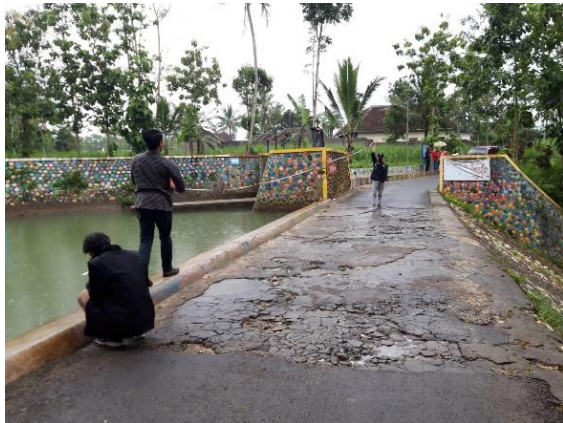
Gambar 12. Dokumentasi Survey di Dam Mahardho
