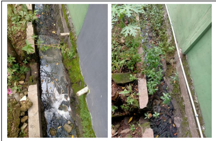
Gambar 1. Sejumlah saluran air memiliki aliran yang tidak lancar akibat tumpukan sampah
